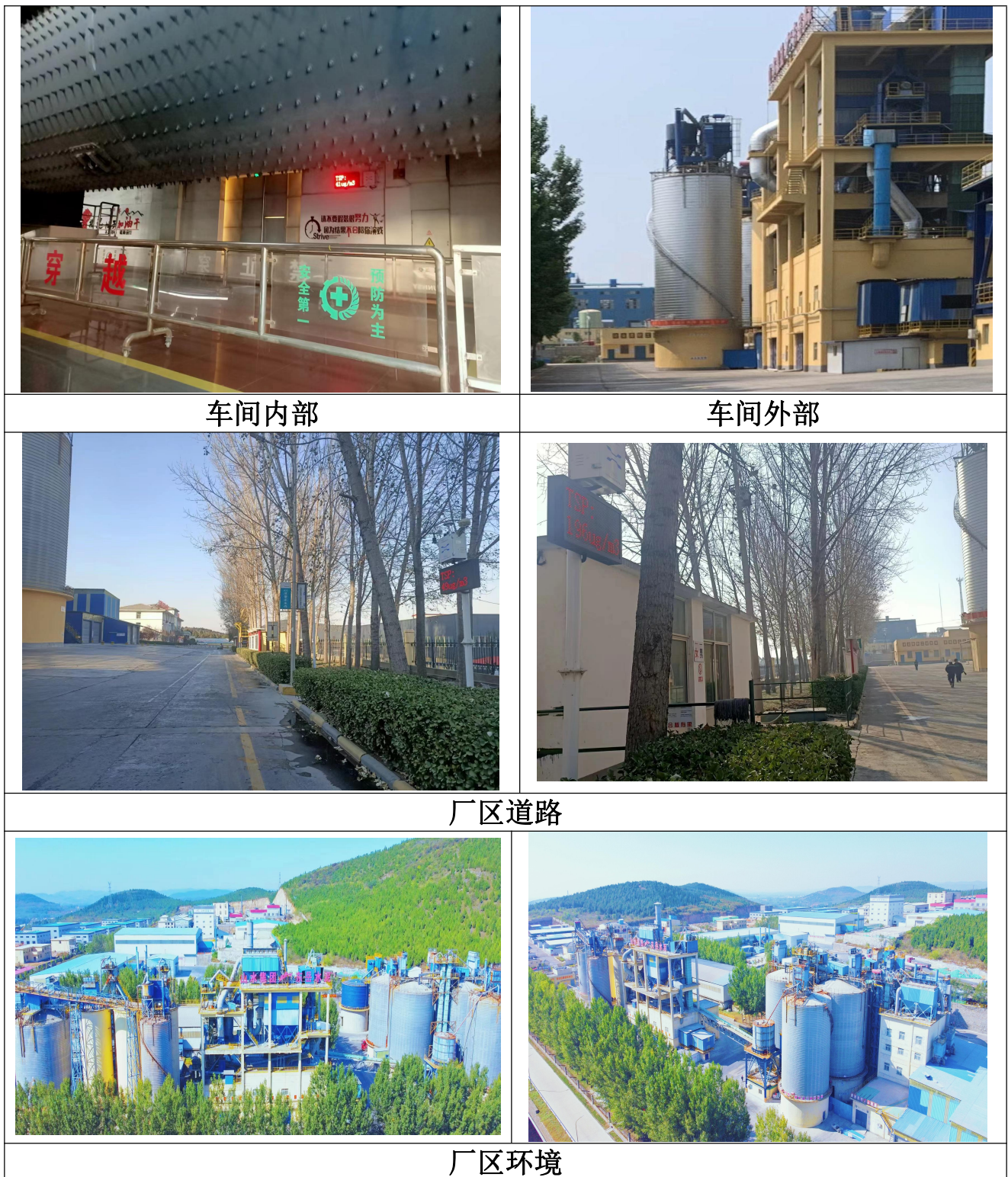
图 8 厂区环境现场情况
